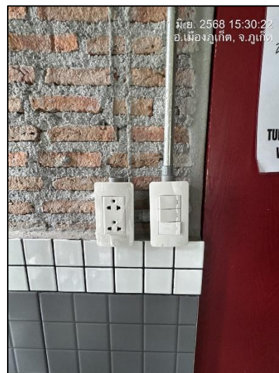
รูปภาพที่ 2.16 สวิทช์ควบคุมไฟฟ้าสองดวง
